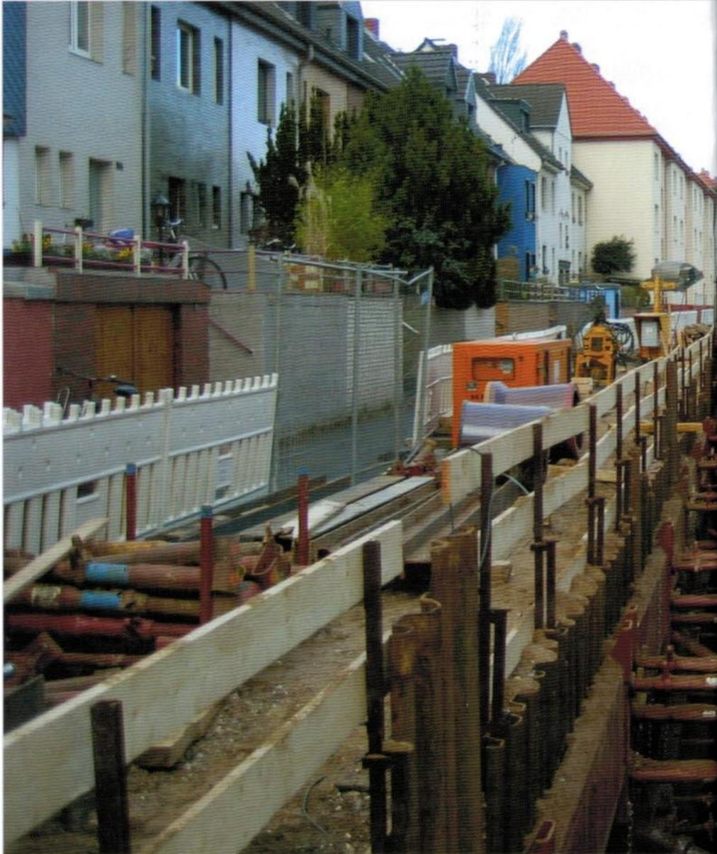
Die StEB Köln verbessern im Einzugsgebiet von Köln-Marienburg den **Überflutungsschutz** durch eine Vergrößerung der Speicherkapazität des Kanalnetzes. In Koordination mit den Arbeiten für die Stadtbahn wird die Ablaufleistung der Kanäle in der Bonner Straße erhöht. Im Vorfeld wurden alle Kanäle auf ihren baulichen Zustand hin überprüft und soweit erforderlich saniert.
