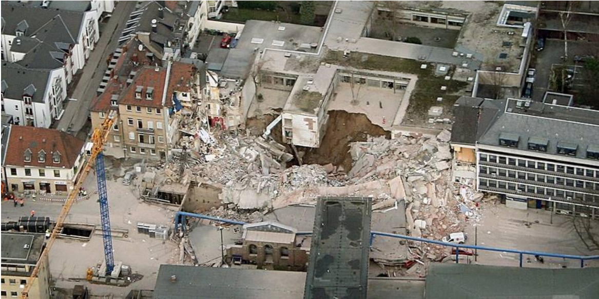
Blick auf das eingestürzte Historische Stadtarchiv in der Innenstadt von Köln. Foto: dpa
