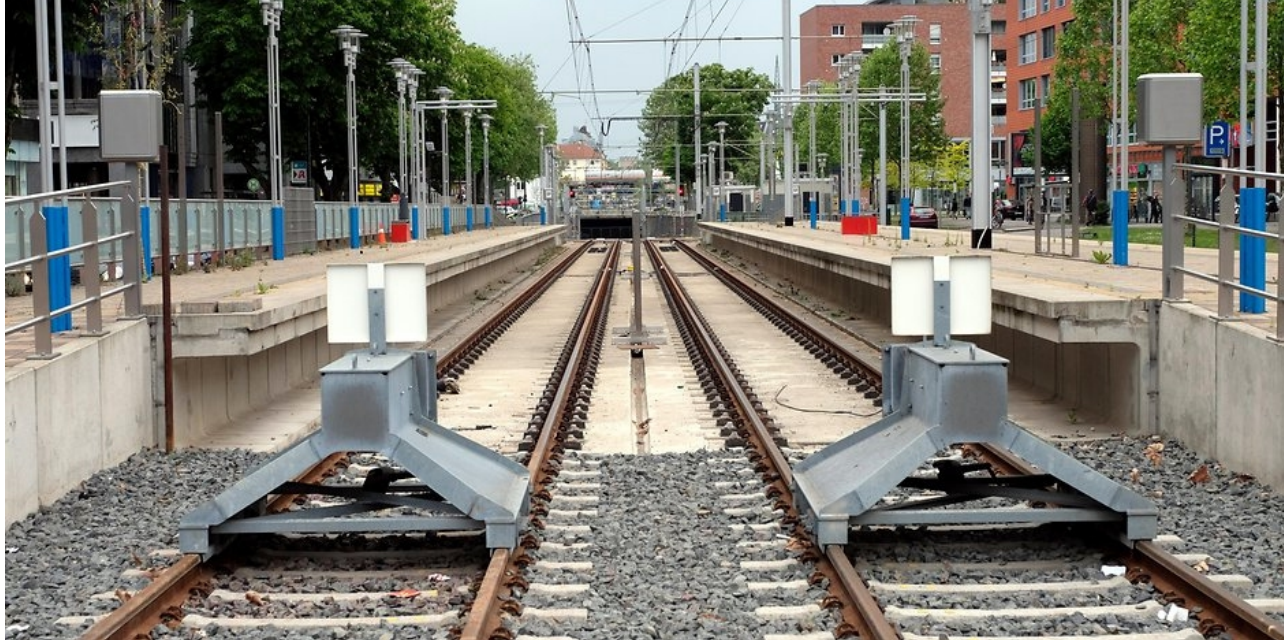
Die Haltestelle Bonner Straße der Nord-Süd-Stadtbahn in Köln. Foto: Grönert
