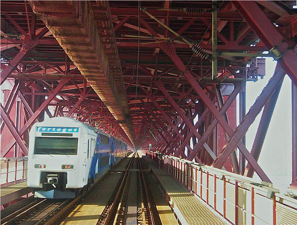
Bei der Tejo-Brücke in Lissabon fährt die Bahn auf der unteren Ebene
