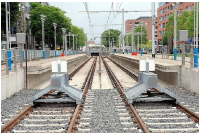
Die Haltestelle Marktstraße müsste umgebaut werden, damit dort Niederflurbahnen halten können.
