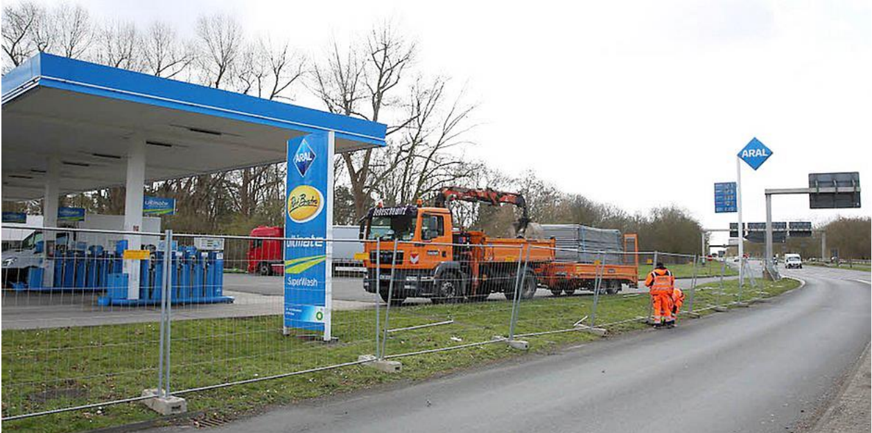
Die östliche Aral-Tankstelle am Verteilerkreis wird abgerissen. Foto: Goyert
