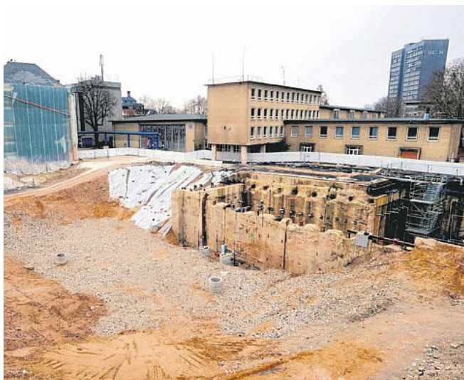
Noch bis 2017 wird die Staatsanwaltschaft hier ermitteln. Dadurch verzögert sich der gesamte U-Bahn-Bau. Foto: Alexander Schwaiger
