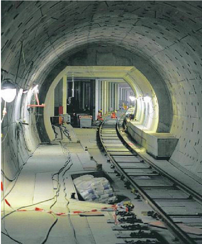
Die Gleise liegen bereit. Deshalb soll zumindest bald ab Severinstraße die U-Bahn Richtung Sürth rollen. Foto: Stefan Worring
