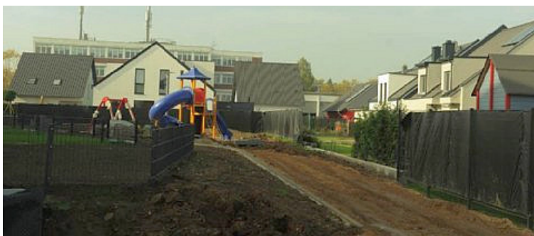
Gebaut wird nicht nur auf dem Sürther Feld, überall im Kölner Süden sind Neubauprojekte geplant. Foto: Worrying
