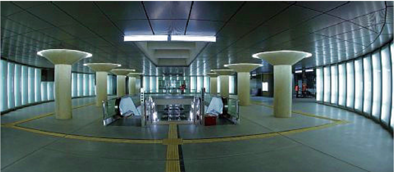
Betonpilze tragen die Decke der Zwischenebene in der Haltestelle Chlodwigplatz. Lichtschächte sorgen für direkte Helligkeit, Neonröhren hinter Milchglas für indirektes Licht. (Fotos: Schmülgen)
