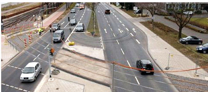
Künftig sollen Ampeln den Verkehr an der Kreuzung der Nord-Süd-Bahn mit der Rheinuferstraße regeln. Foto: Peter Rakoczy
