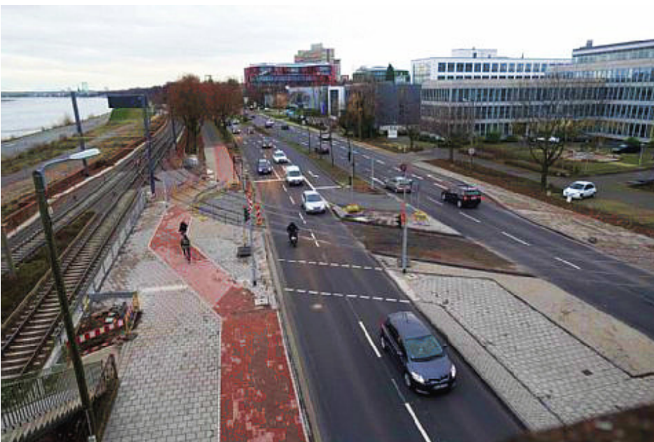
Die flexible Ampelschaltung soll die Situation entzerren. Foto: (Foto: Hanano)
