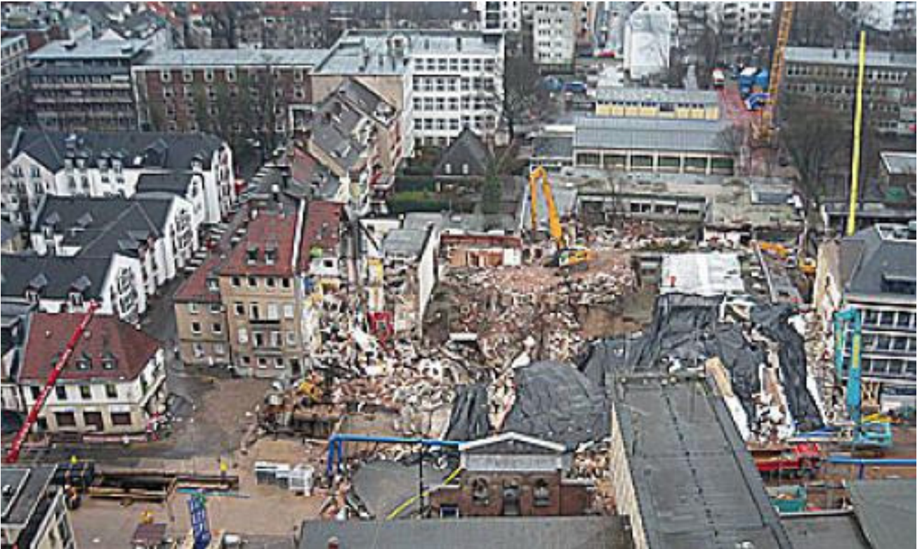
Die Einsturzstelle des Historischen Archivs der Stadt Köln im Jahre 2009 (Archivfoto).
