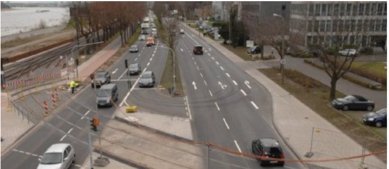
Künftig sollen Ampeln den Verkehr an der Kreuzung der Nord-Süd-Bahn mit der Rheinuferstraße regeln. Foto: Peter Rakoczy
