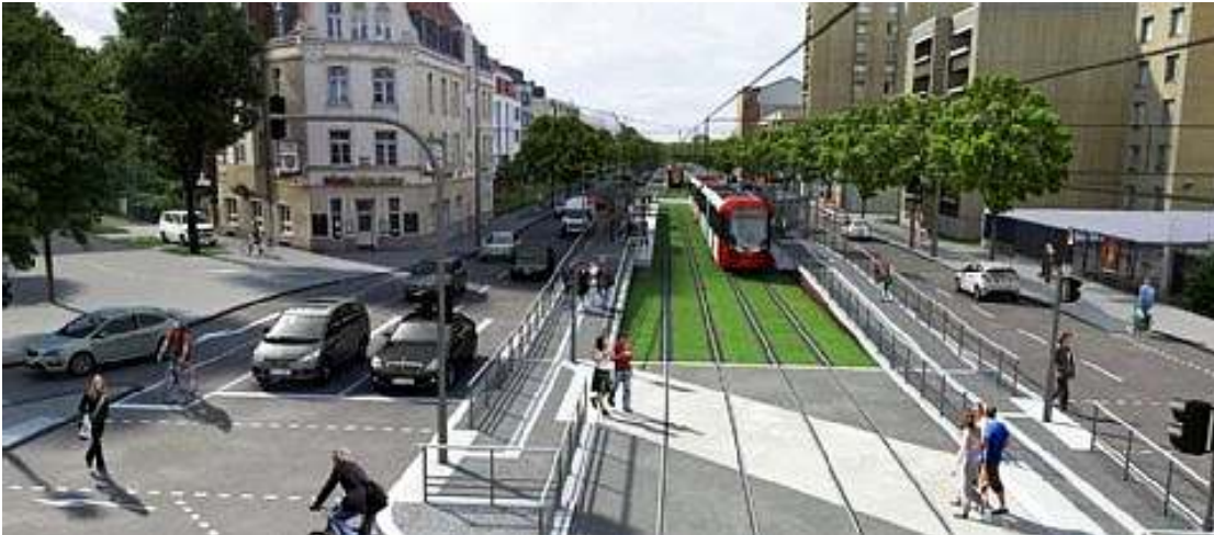
Die Einmündung der Brohler Straße (links) wird nach dem Umbau einem Platz gleichen. Foto: Visualisierung: Stadt Köln
