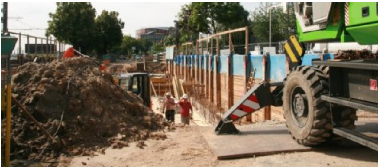
Arbeiten in Zusammenhang mit der Nord-Süd-Bahn in Höhe der Südbrücke – Ende Juli sollen sie abgeschlossen ein. Foto: Süsser
