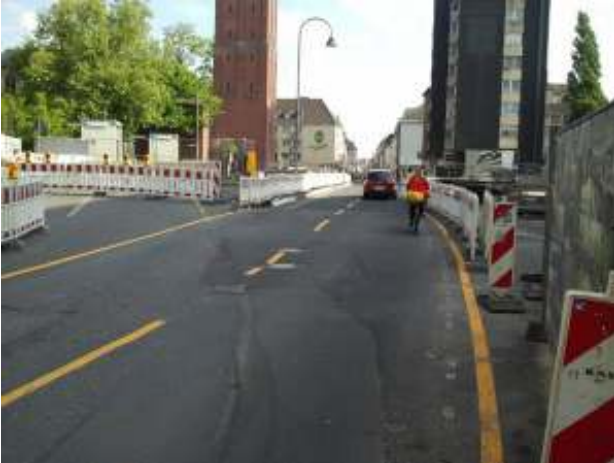
Seit dem vergangenen Wochenende läuft der Verkehr auf der Severinstraße über den Perlengraben auf dem neuen Brückenbauwerk. Links davon war die alte Brücke. Bild: Köln Nachrichten
