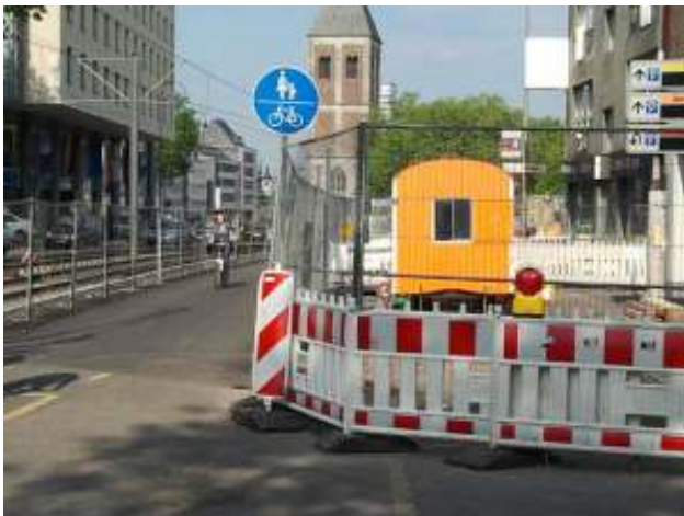
Im September 2013 soll hier wieder der Autoverkehr in Richtung Deutzer Brücke fließen. Bis dahin kommen nur Radfahrer und Fußgänger durch. Bild: Köln Nachrichten
