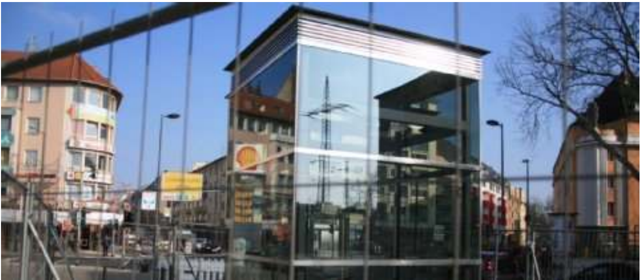
Die Aufzugshäuschen am Bonner Wall sind fertig. Dahinter wird die Linie 17 die neue Trasse verlassen und zum Rheinufer geführt. Foto: Philipp Haaser
