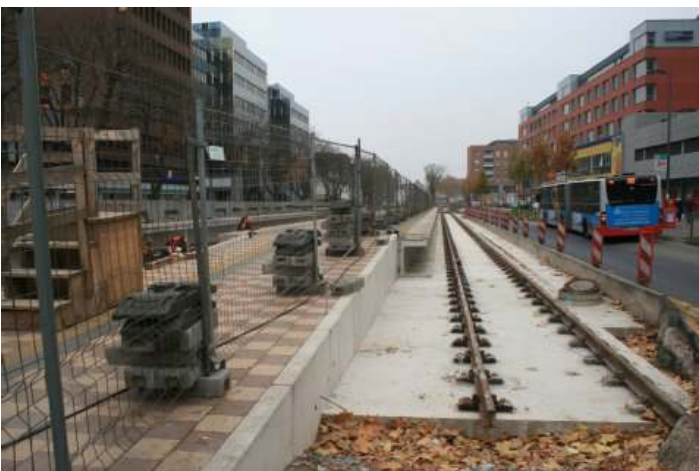
In der Mitte der Bonnerstraße werden ab 2016 Straßenbahngleise verlegt. Foto: Philipp Haaser
