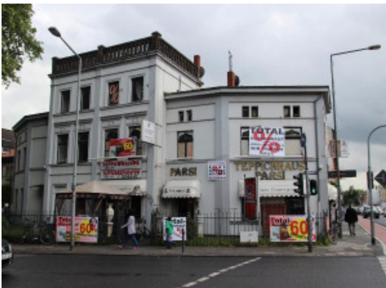
Soll für eine Rechtsabbiegerspur abgerissen werden: "Villa Lenders" an der Kreuzung Bonner/Schönhauser Straße. Foto: ehu
