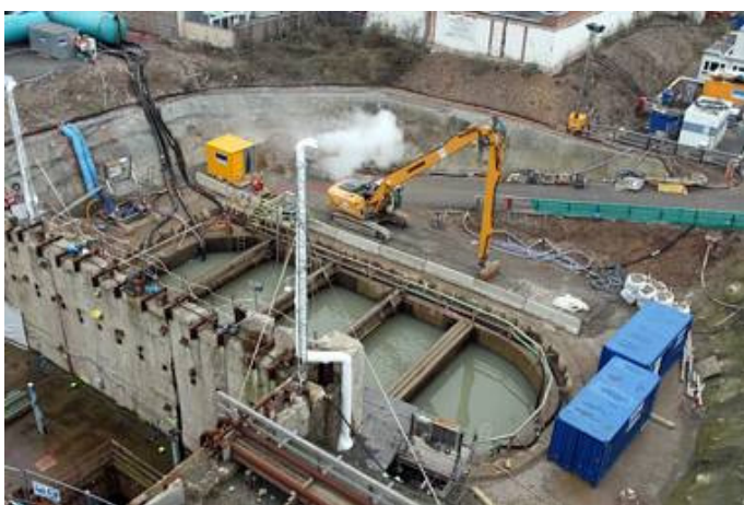
Spurensuche: Derzeit arbeiten Taucher in der Bergungsbaugrube. Bald soll eine tiefere Beweissicherungsgrube entstehen. (Foto: Hanano)
