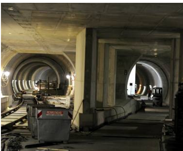
Zwei Gleistunnel werden zusammengeführt. (Bild: Worring)
