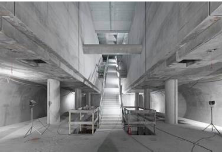
Der Rohbau ist fast fertig: Im Verflechtungsbauwerk Bechergasse/Kurt-Hackenberg-Platz werden zwei Linien kreuzen. (Foto: KVB)
