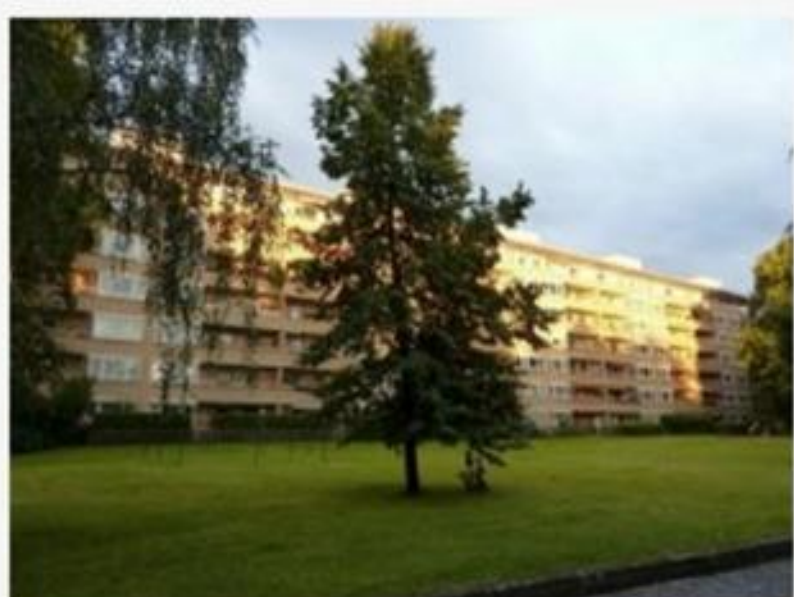
Ein Wohnblock in der Siedlung Heidekaul
