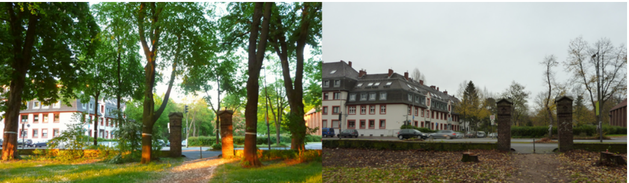
Ein Fuß- und Radweg soll an der Straße und nicht um die Bäume herum angelegt werden. Die Friedhofsmauer wird noch abgebrochen.
