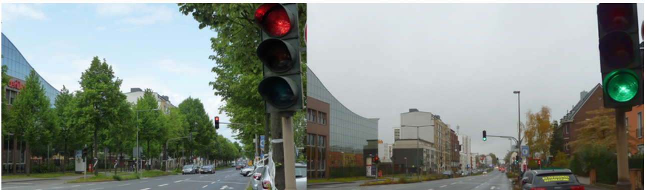
Für eine künftige Baumallee wurden die Bäume gefällt.
