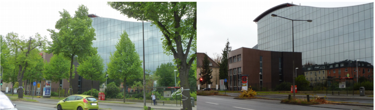
Die Bushaltestelle Gaedestraße hat ihren Charme verloren. Sie wird ebenfalls für die Bahnstrecke entfallen.
