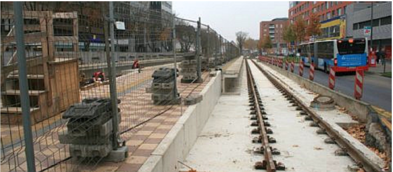
In der Mitte der Bonnerstraße werden ab 2016 Straßenbahngleise verlegt. Foto: Philipp Haaser
